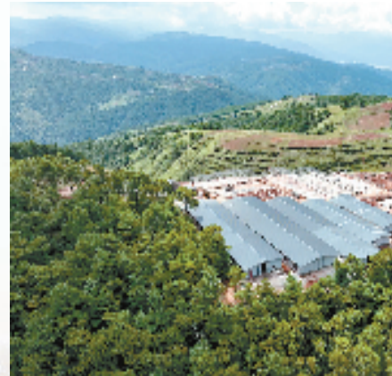
海曙区援建四川攀西地区高海拔养殖基地新建棚舍施工现场
