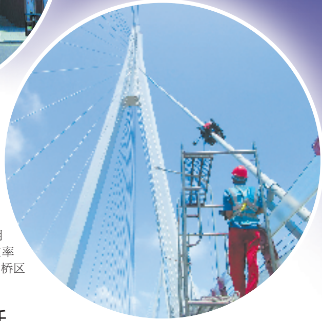
大桥进行斜拉索检测
