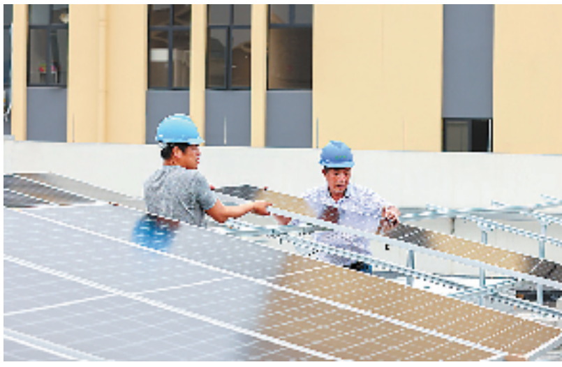
位于德清县乾元镇的浙江万森电子科技有限公司，工人们正在屋顶安装光伏面板。 蔡俊 摄
