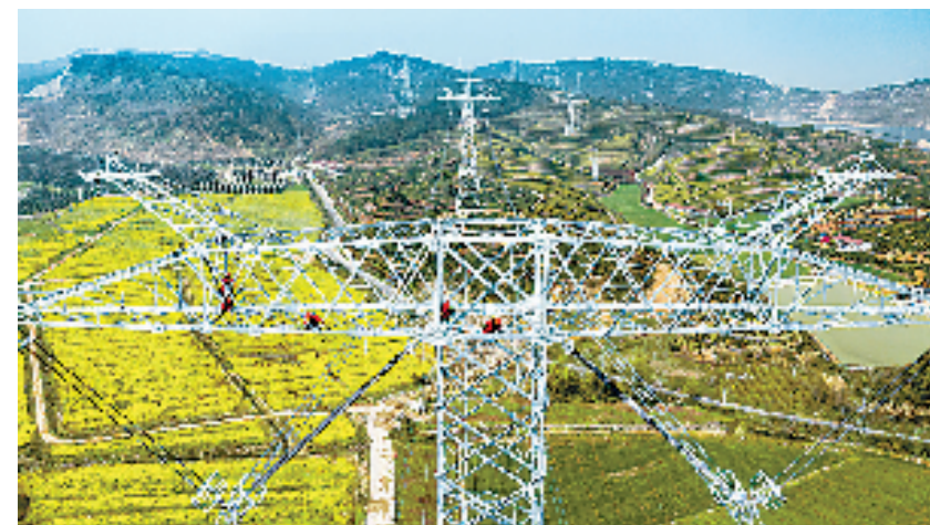
白鹤滩—浙江±800千伏特高压直流输电工程湖州段 (图片由国网湖州供电公司提供)
