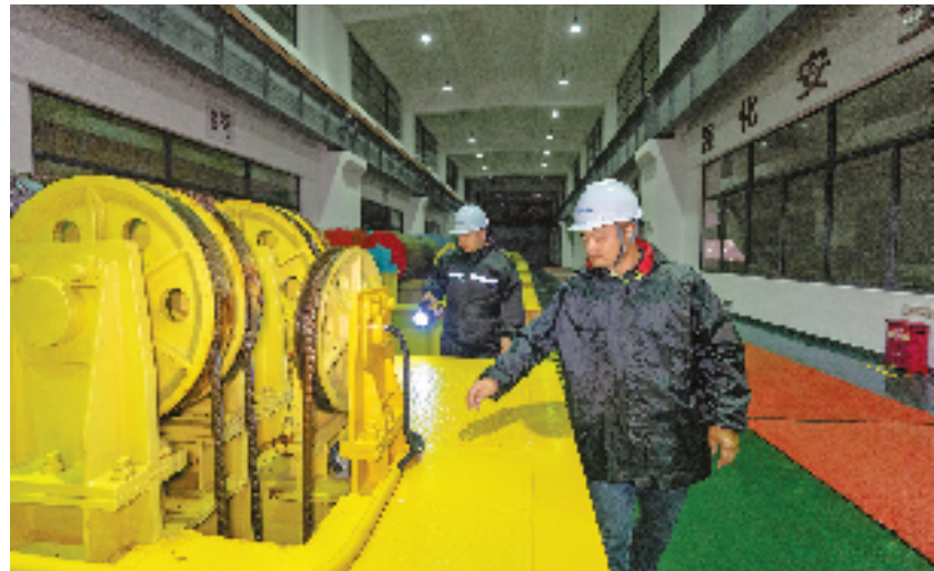
为保证安全度汛,宁波北仑梅东大闸全体工作人员彻夜值守,通过远程监控和定点巡查等方式,确保一应水利设施正常运转。 本报记者 贺元凯 应磊 摄
