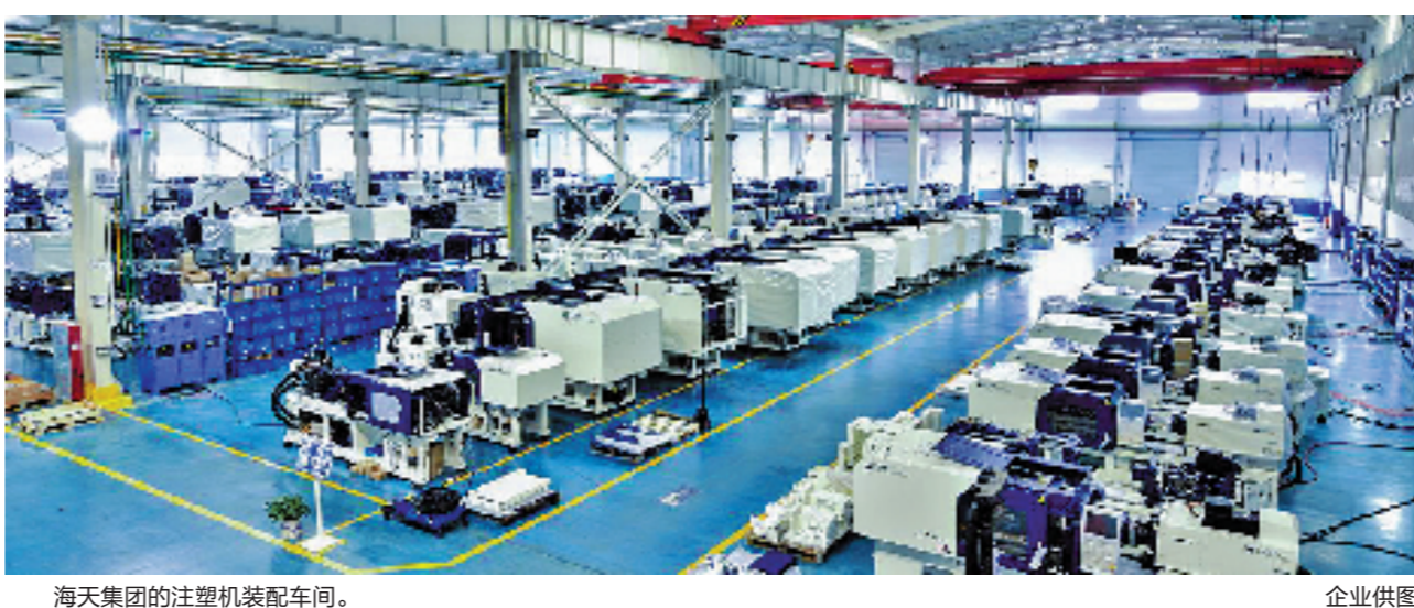
海天集团的注塑机装配车间。
