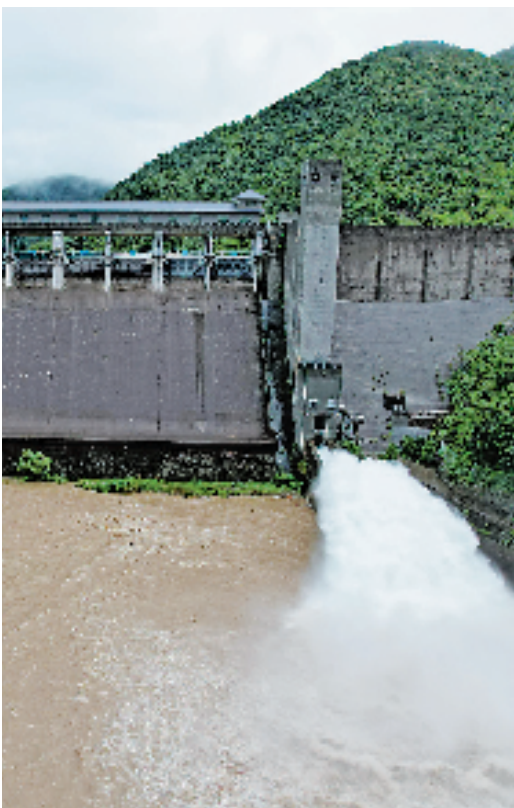
9月3日11时30分,位于四明山区的宁波皎口水库开闸预泄。 本报记者 应磊 拍友 陈结生 摄
