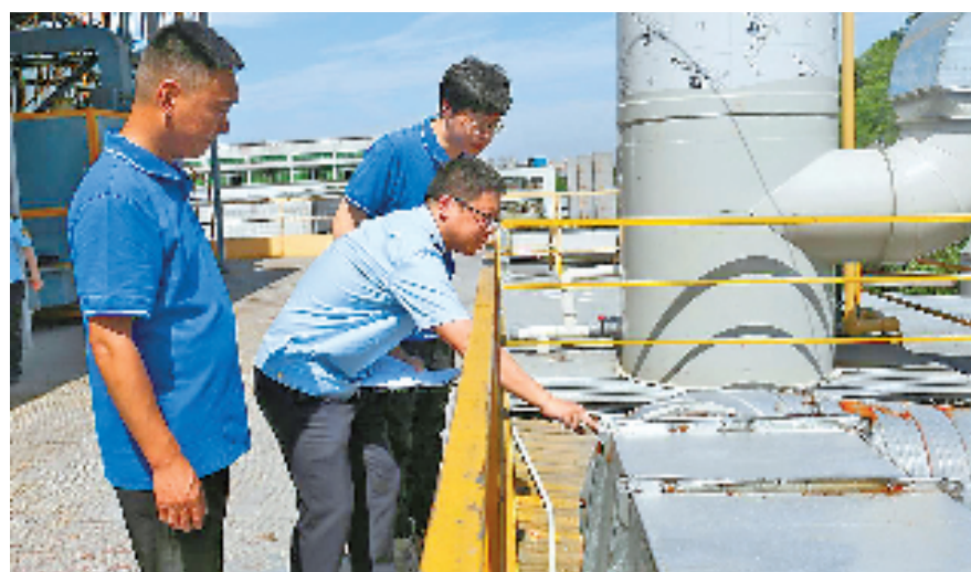
环保执法人员对废气处理设施进行检查。
