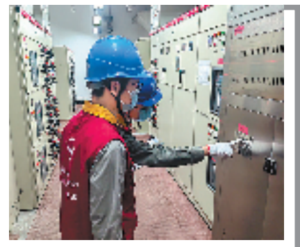
电力员工对改造设备进行现场查勘
