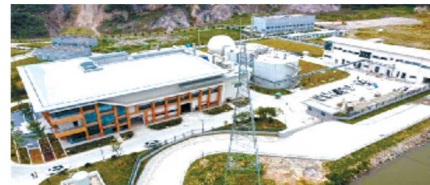
永嘉县餐厨垃圾处置中心 潘智化 摄
