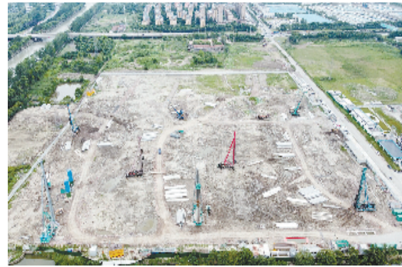
王江泾镇收村安置房项目建设现场 秀洲区王江泾镇人民政府供图
