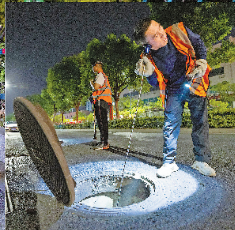
听漏工用听漏棒确认地下供水管网是否有漏点。
