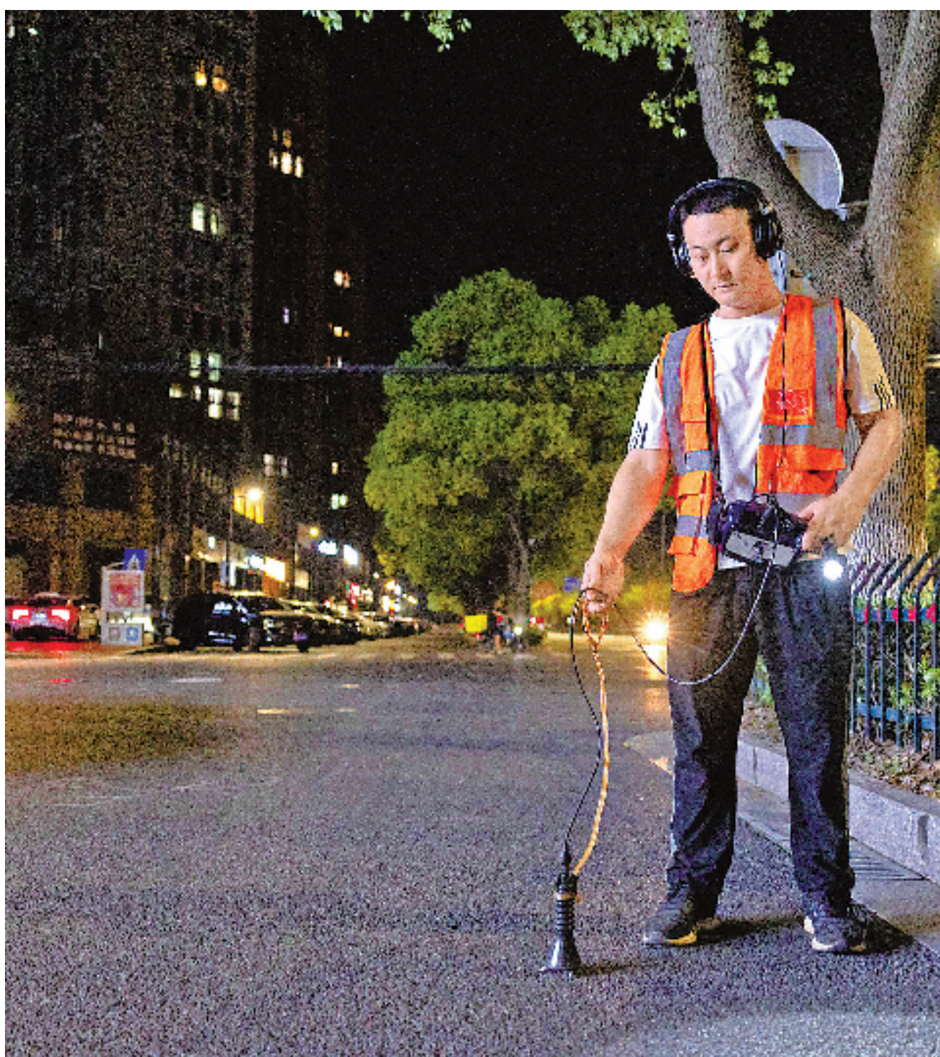
听漏员对地下供水管网进行听漏“巡诊”。
