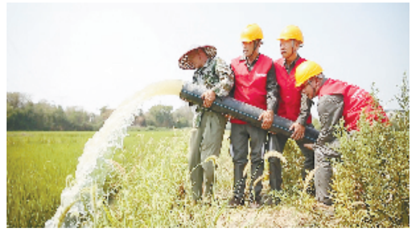
8月19日,在德清县钟管镇蠡山村,国网德清县供电公司服务队主动为农户提供安全用电技术指导 and 咨询服务,协助检查供电线路、农用灌溉站、水泵控制柜等设备,助力抗旱保收。陈海龙 摄
