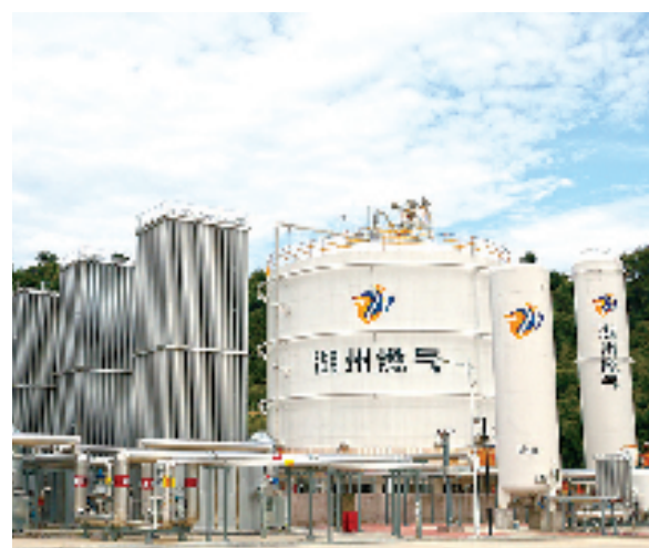
湖州LNG应急储配站
