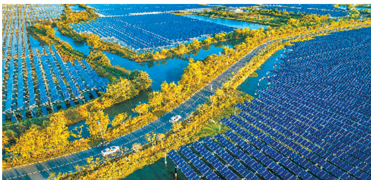
南浔和孚桑基鱼塘光伏发电 沈勇强 摄
