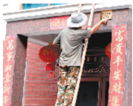
工作人员为盛和新村居民安装门牌。（图片由建德市寿昌镇人民政府提供）
