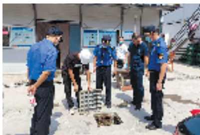
望江街道综合行政执法队对建筑工地开展“综合查一次”。(图片由上城区望江街道提供)
