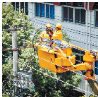
国网台州市黄岩区供电公司员工进行电网设备安全隐患排查。(图片由国网台州市黄岩区供电公司提供)
