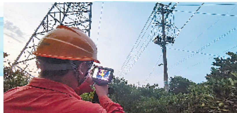
国网常山县供电公司招贤供电所线路运维人员在开展10千伏线路红外测温 郭旭 摄
