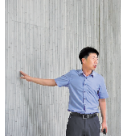
徐锡平正在项目现场查看竹纹清水混凝土制作工艺。
