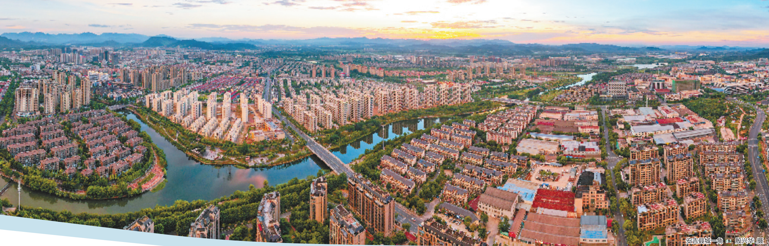
安吉县城一角 殷兴华 摄
