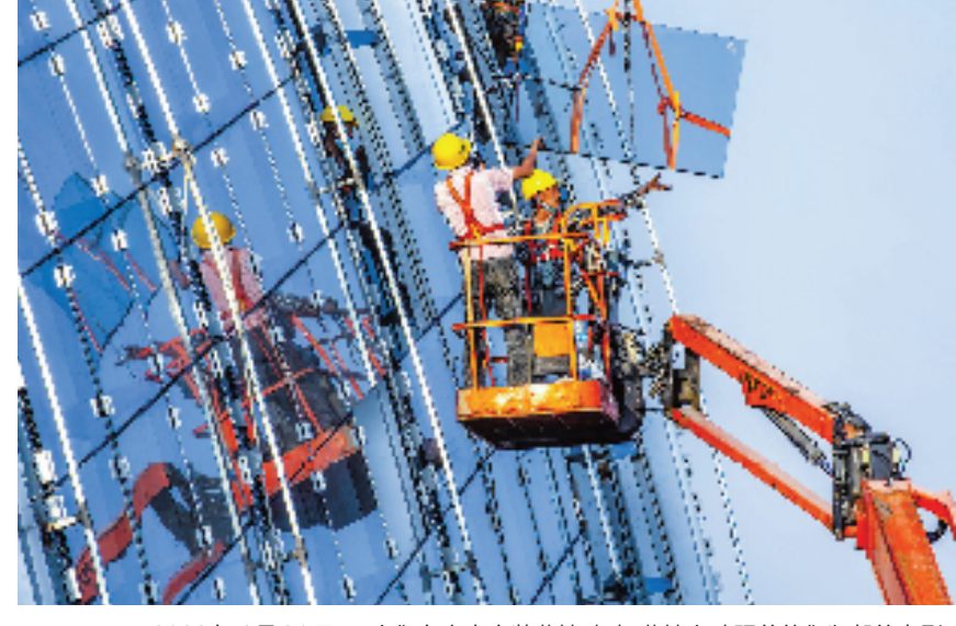
2022年4月21日,工人们在高空安装幕墙玻璃,幕墙上映照着他们坚毅的身影。
