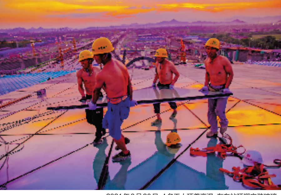
2021年8月30日,4名工人顶着高温,在车站顶棚安装玻璃。
