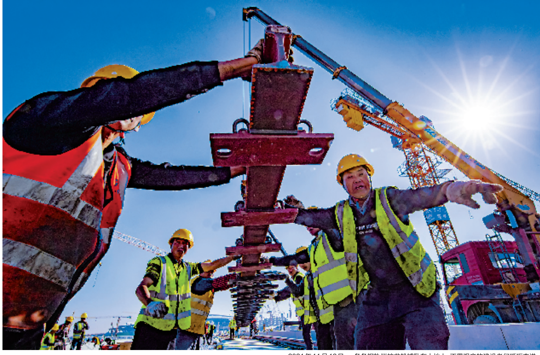
2021年11月12日,一条条钢轨以蛟龙般铺卧在大地上,不畏艰辛的建设者们砥砺前行。
