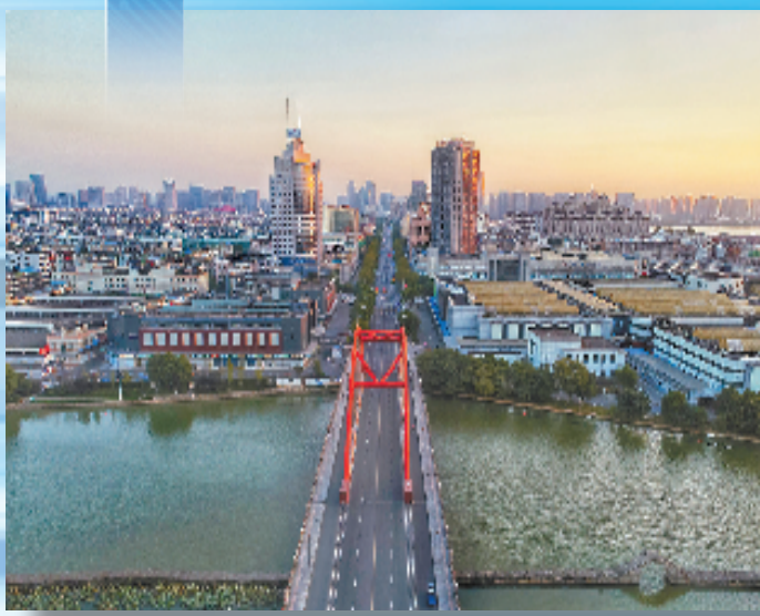
柯桥区钱纺大桥
