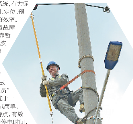
电力施工人员在固定线路故障预警定位装置 陈海卯 摄
