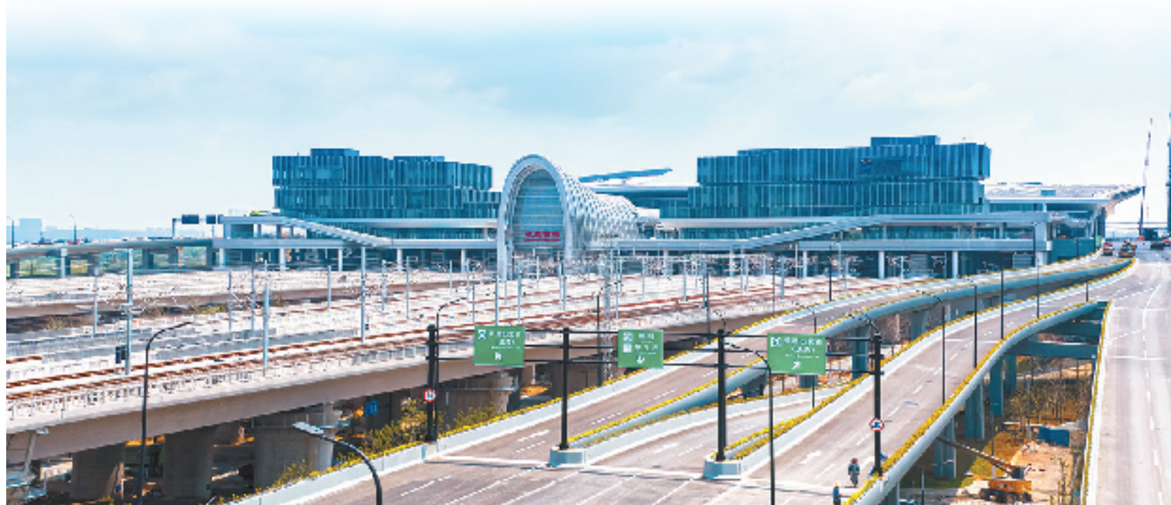
即将建成运营的合杭高铁湖州段杭州西站
