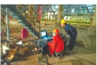
技术人员在球罐外部操控机器人进行罐内作业(图片由浙江省特种设备科学研究院提供)
