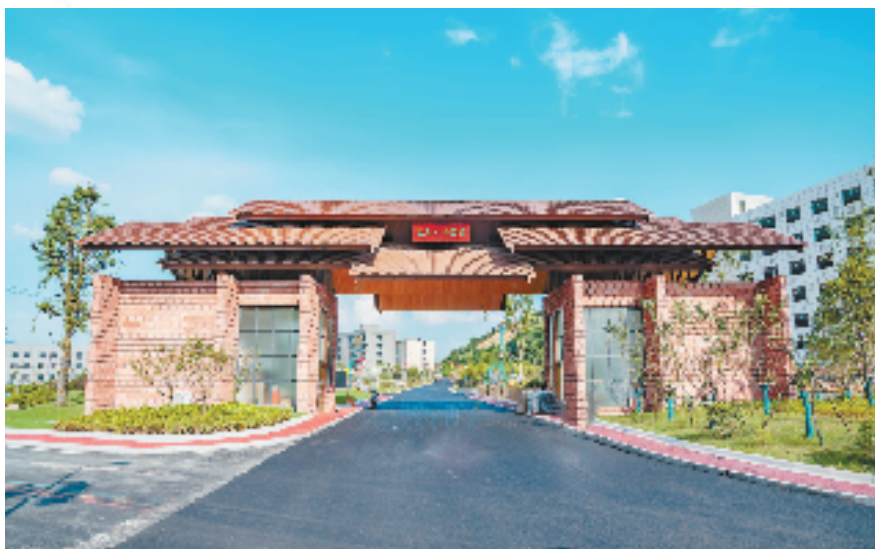
观前村周公坞自然村进村门楼
