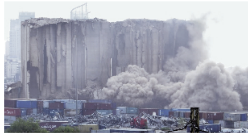
黎巴嫩贝鲁特港口粮仓曾在2020年8月4日发生的大爆炸中受损严重。2022年7月31日,这座高48米、能储存10万吨粮食的大型粮仓部分坍塌掀起滚滚烟尘。新华社发
