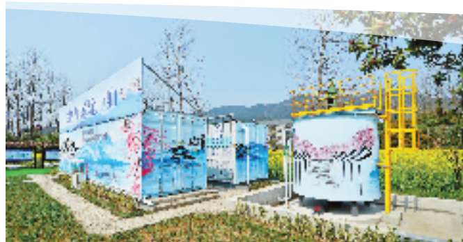
天地环保公司承接桐庐农村生活污水治理示范项目
