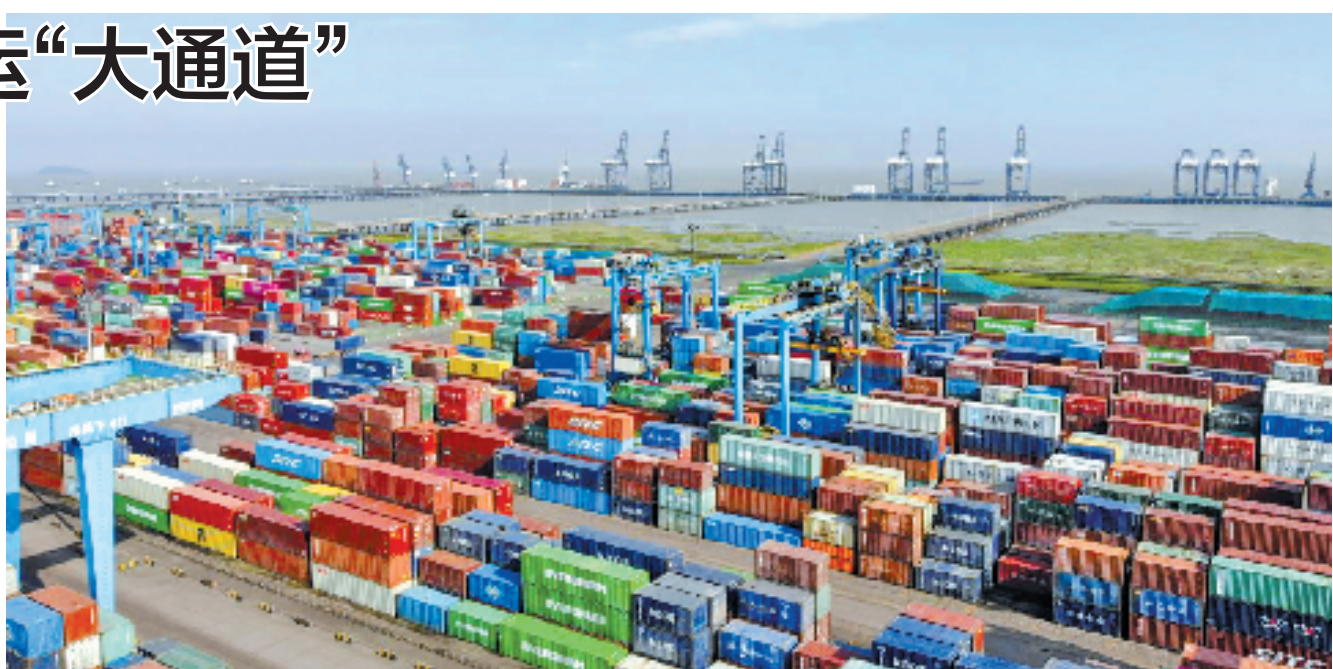
今年上半年,嘉兴完成海河联运吞吐量1481.79万吨、海河联运集装箱吞吐量34.48万标箱,同比分别增长2.24%、70.50%。图为嘉兴港乍浦港区集装箱堆场(资料照片)。
