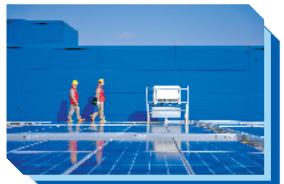
绍兴电力巡检屋顶光伏项目
