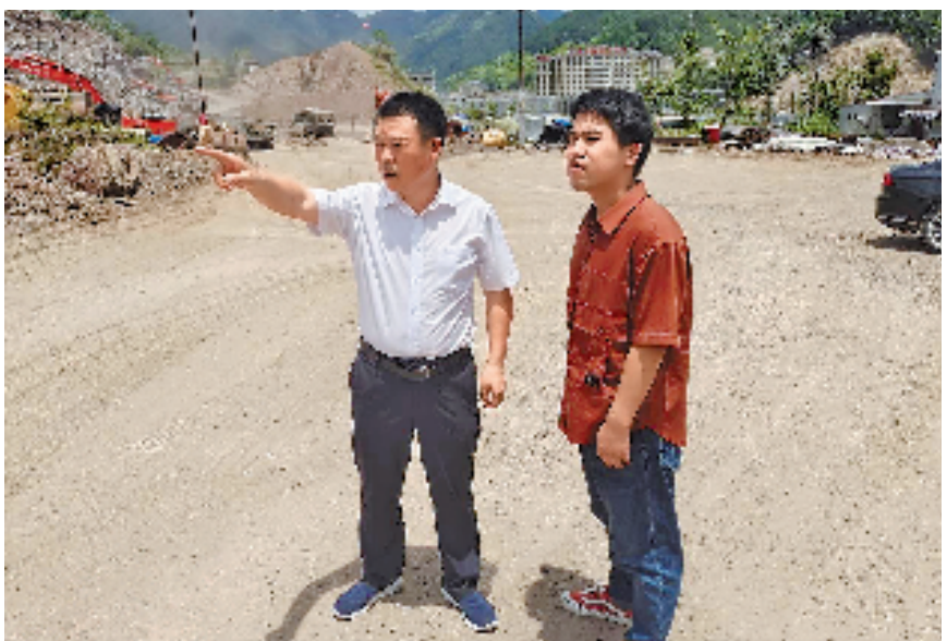
林森(左)和同事紧盯项目施工现场。 拍友 罗锦建 摄
