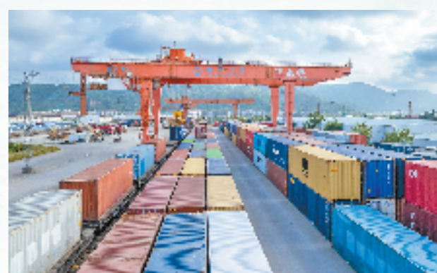
智慧物流铁路货运南站
