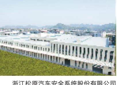
浙江松原汽车安全系统股份有限公司新项目
