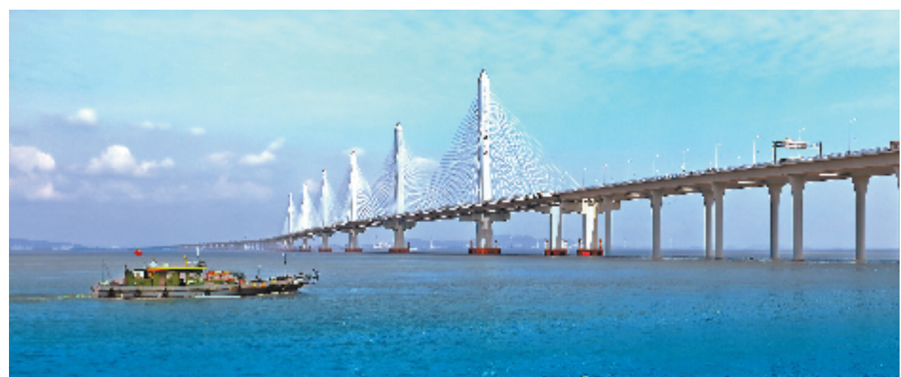
智慧大桥赋能嘉绍两地高质量发展
