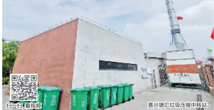
嘉兴塘汇垃圾压缩中转站。
