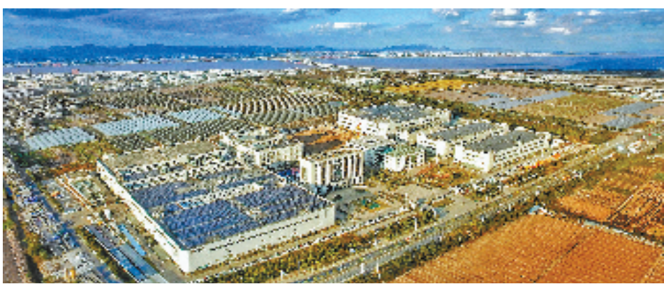
“浙里光谷”核心区——水晶光电产业园
