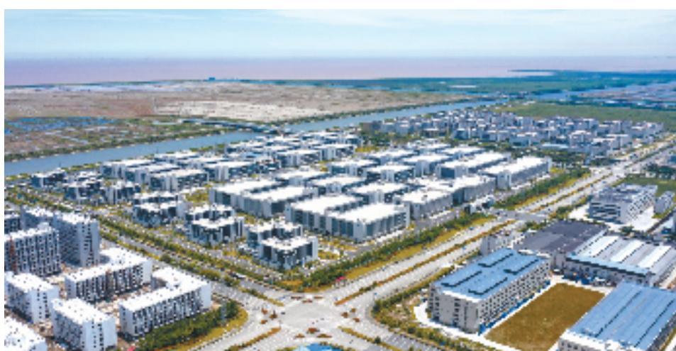
前湾新区数字经济产业园
