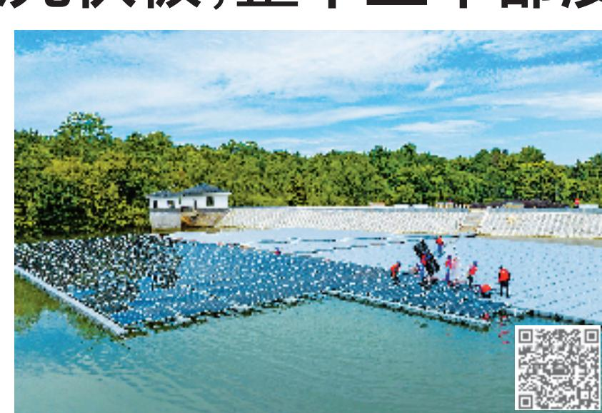
“早上六点就开工了，整个上午都没停过，下午继续干，争取早日完工。”石旭峰告诉记者，公司采取“做两头、歇中间”的方法，在室外温度过高的时段，会要求他们停止作业，“天气凉快的时候，我们一天能安装240块左右光伏板，如果热的话，也能装200块左右。”这个项目要赶在7月中旬完工。整个项目安装光伏组件3700多件，现在已安装近3000件。
