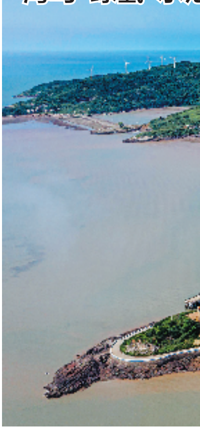
7月8日,全国首个海岛“绿氢”综合能源示范工程——国家电网浙江台州大陈岛氢能综合利用示范工程投运。据了解,该工程可以利用海岛富余风电进行电解水制氢,每年产生的氢气可发电约10万千瓦时,减少二氧化碳排放73吨。图为该工程航拍远景。
