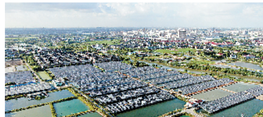
位于桐乡市洲泉镇的渔光互补电站,年均发电量可达2000万千瓦时。
