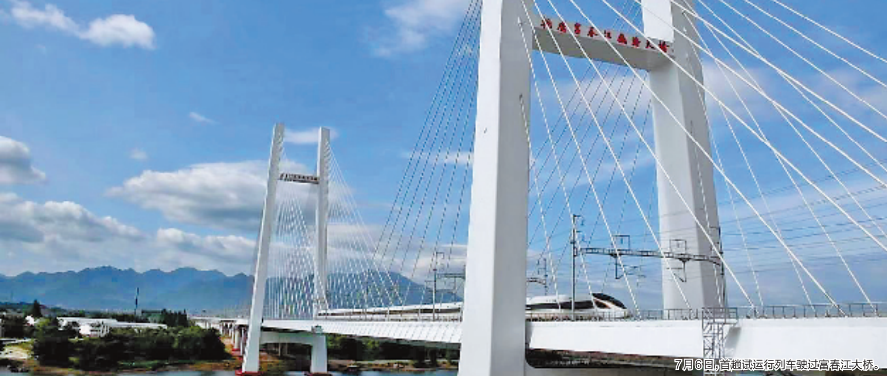
7月6日首趟试运行列车驶过富春江大桥。
