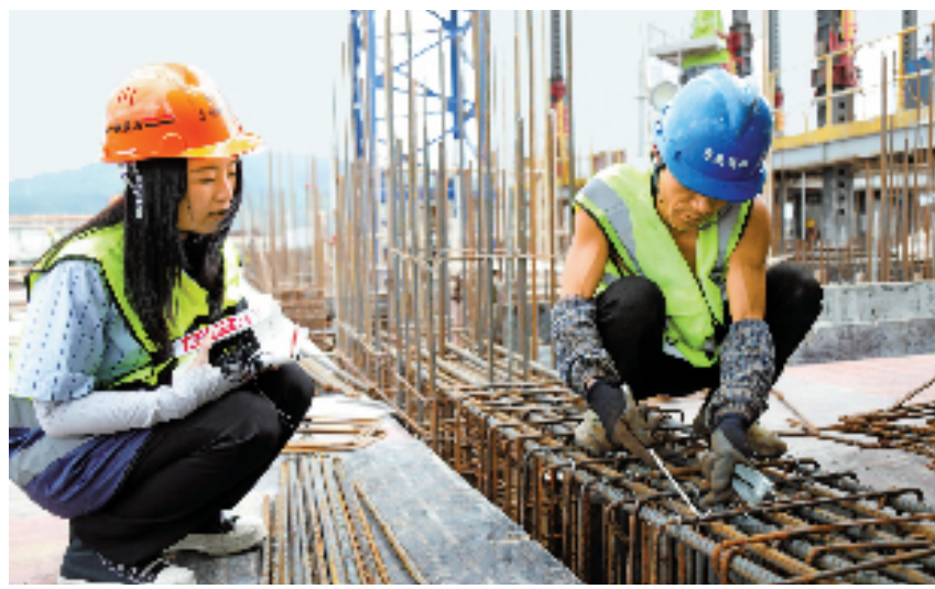
本报记者在建筑施工现场体验。
