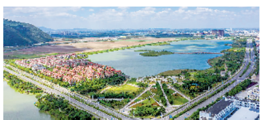
高质量推进慈东现代化小城市建设
