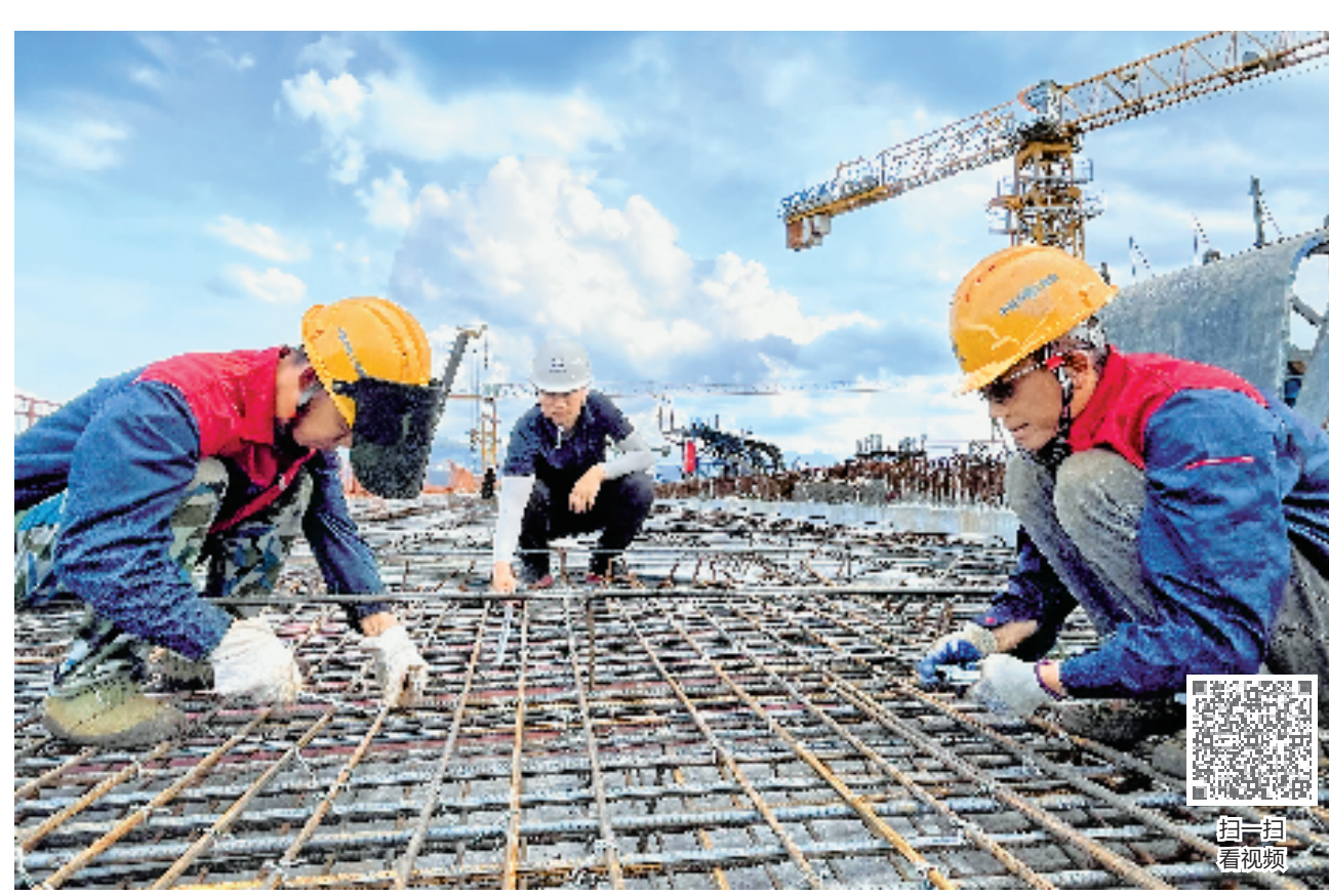
尹成龙(中)在检查钢筋的间距。
