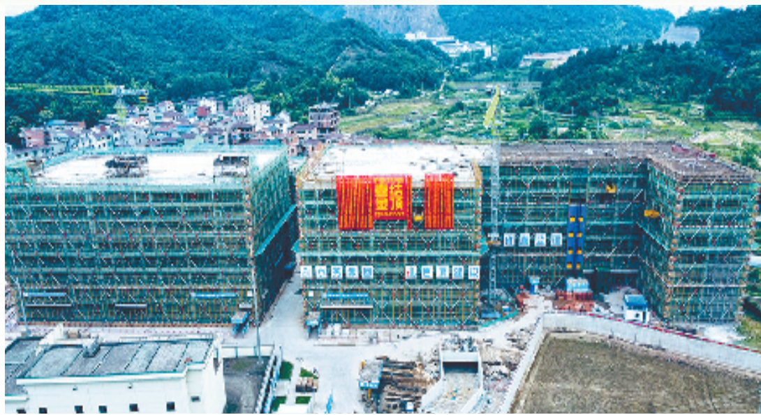
近日，国企结对项目之一赤岸镇农村共富产业园项目封顶。
