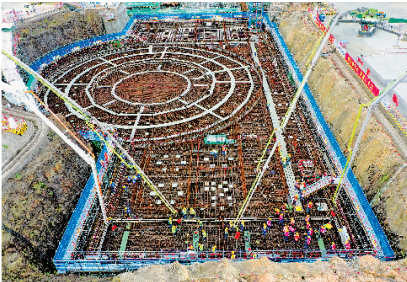
6月28日上午,三门核电二期工程3号机组核岛反应堆厂房筏基底板开始浇筑混凝土,标志着该工程正式开工。
