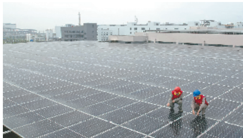
国网瑞安市供电公司员工为企业用户检查屋顶光伏发电设备。(图片由国网瑞安市供电公司提供)
