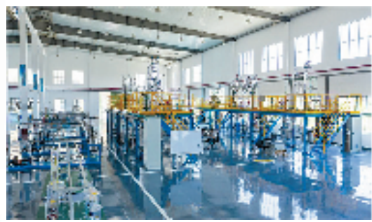
绿色化工人才公共实训中心
