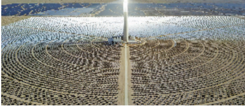
2022年6月8日在青海省海西蒙古族藏族自治州德令哈市光伏(光热)产业园拍摄的青海中控德令哈50兆瓦光热电站。新华社记者 范培坤 摄
