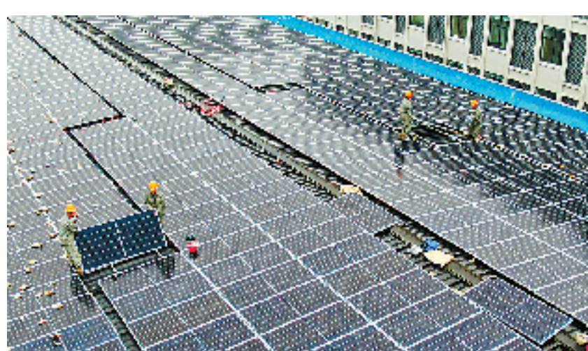
电力施工人员正在屋顶铺设光伏板
