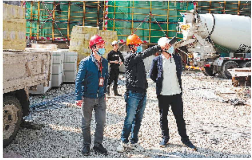
在湖州市委政法委和驻委纪检监察组的指导下,德清县委政法委联合纪检监察、组织、建设等部门对建筑工地安全生产开展联动督查,推动除险保安、市域社会治理等各项工作提质增效。俞峰云 摄
