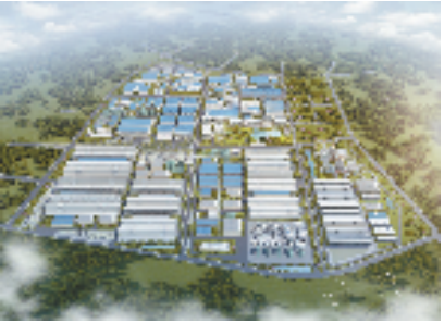
支持浙江时代锂电材料国际产业合作园项目建设
